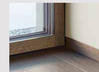
Sockelleiste mit flächenbündigem Wandabschluss
